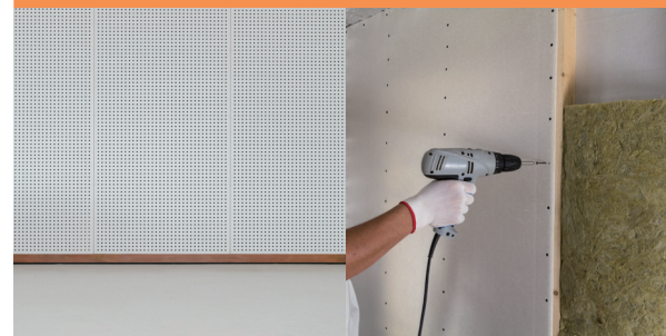
防音壁／窓や壁の防音工事
