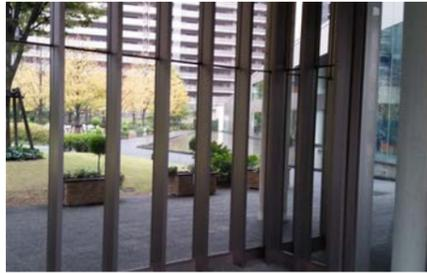
入口はガラスと柱で重機が入れなかったため、ガラスを外し柱を切断して取り外し可能な仕様に。今後の修繕も見据えた計画・提案が行われました。
