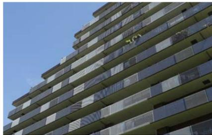
柵に隠れて防水塗装が行えない部分は、柵を上下逆に仮設置し露出させて塗装するというアイデアでコストアップを回避。
