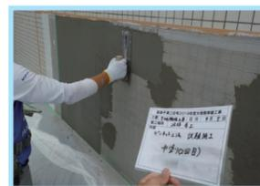
最後に2回目中塗り塗装をして補修の完了。今回は塗装仕上げを施しましたが、再度タイルを貼るなど、別の仕上げを選ぶことも可能です。
