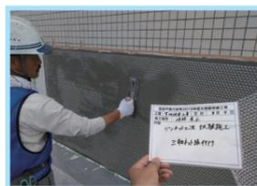
続いて、ネットの貼り付けを行います。三軸ネットは縦・横・斜めの3方向に伸びるという特性で変形に追随し、剥落防止効果を発揮。
