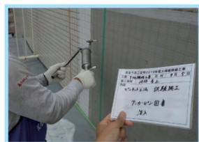
貼り付けが完了したら、アンカーピンでネットを固定していきます。まずは下穴を空け、樹脂を投入。複数の方法で固定することで安定性が向上。
