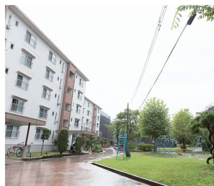
※このページの写真は全て、施工中の物件の様子です。
